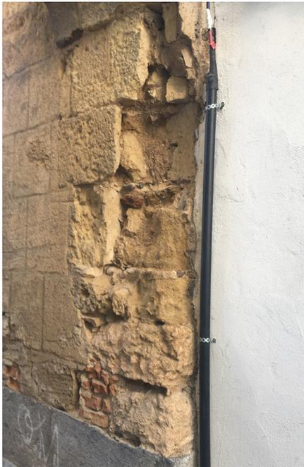
Fig. 2.- Por menor deterioro del pilar del Portillo. Imagen de la autora.
