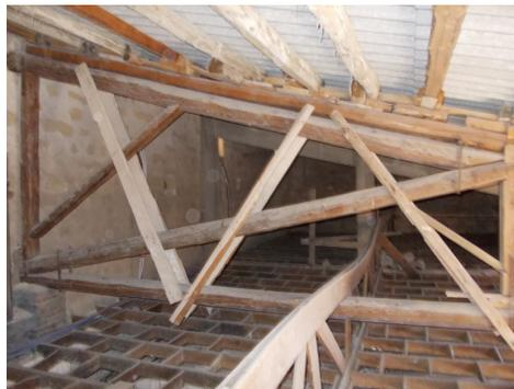
Fig. 4.- Svergolamento del corrente superiore di un traliccio portante del controsoffitto (fonte: Pietro Calamia).
