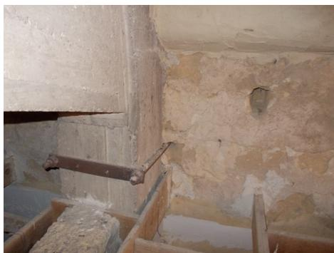
Fig. 6.- Collare di ancoraggio telaio in c.a. – facciata
