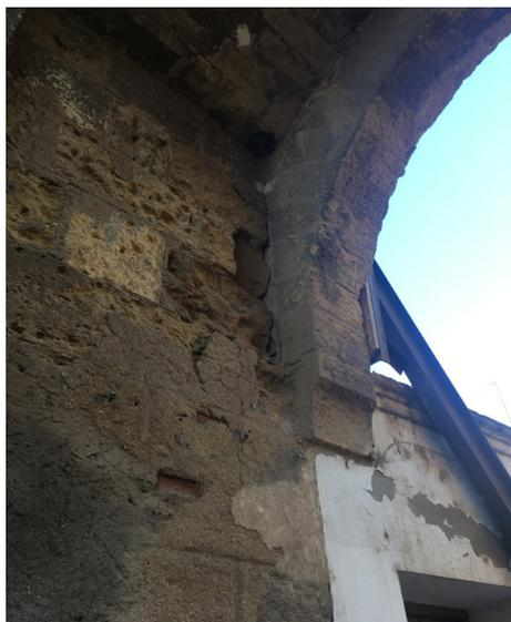
Fig. 4.- Por menor deterioro del trabajo de sillería. Imagen de la autora.
