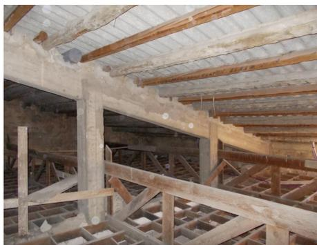
Fig. 5.- Telaio in c.a. esistente
