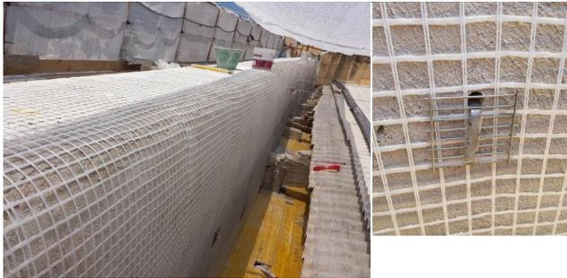
Fig. 18.- Disposizione reti in fibra di vetro e connettori in acciaio inox (fonte: Pietro Calamia).
