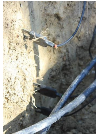
Figura 2. Sondas de humedad instaladas a diferentes profundidades
